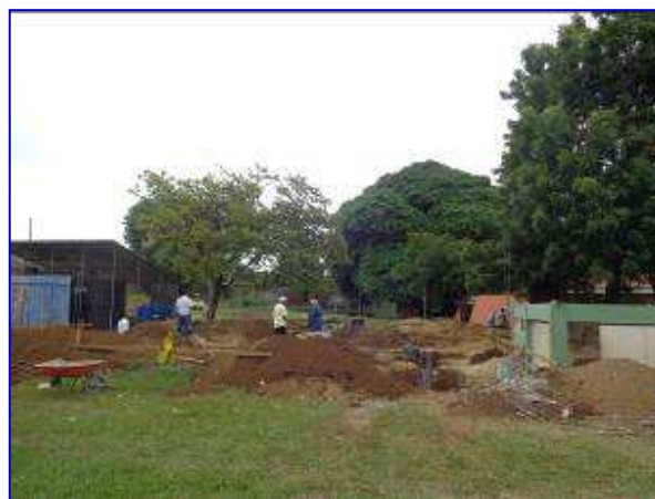
Vista panorámica costado sur oeste, donde se observa la ejecución de las etapas de fundaciones.
