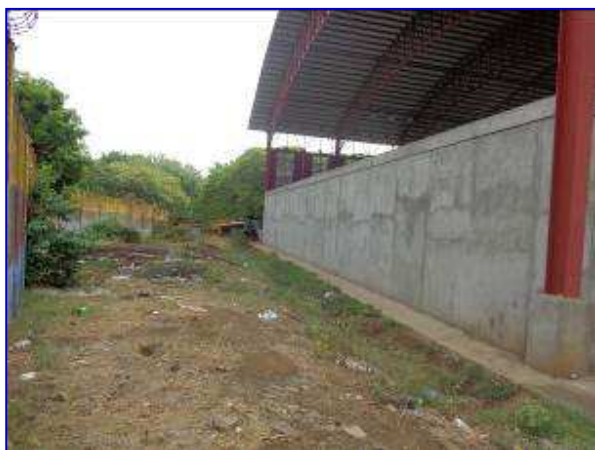
Vista panorámica costado Oeste de la Cancha de Volibol Techado donde se construirá la gradería; situación sin proyecto.
