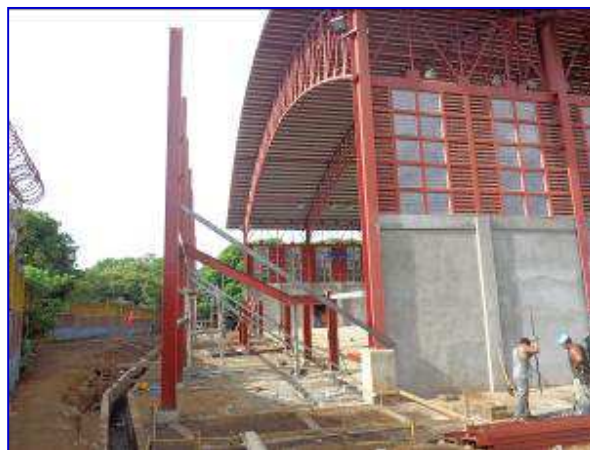
Observar la ejecución de las etapas de preliminares, movimiento de tierra, excavación de canal pluvial, fundaciones para la construcción de Gradería costado Oeste.
