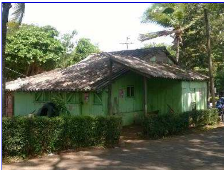
Vista panorámica donde se construirá el edificio de servicios sanitarios, mediante el reemplazo del Puesto de Mando. Situación sin proyecto.
