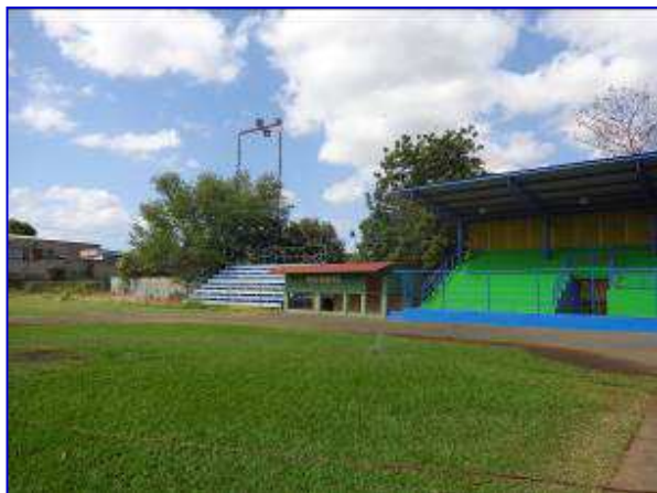
Vista panorámica del área de gradería costado sur oeste, sin proyecto.
