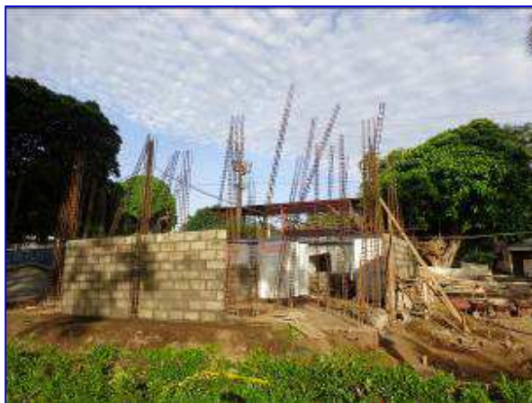
Vista panorámica del área donde se construirá el edificio de servicios sanitarios; apreciar la ejecución de las etapas de preliminares, movimiento de tierra, fundaciones.
