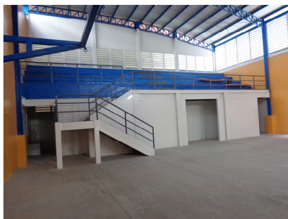
Vista interna de las instalaciones del Gimnasio de Boxeo, sin proyecto.
